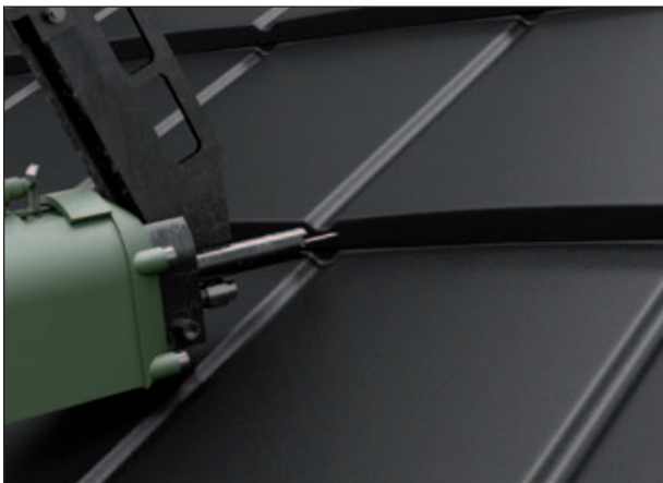
Vzdálenost šroubu od vodící drážky: 15 mm
